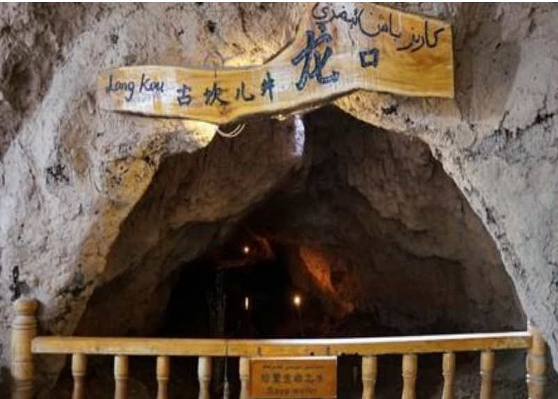
ชลประทานน้ำใต้ดิน ทูลู่ฟานโอเอซิสกลางทะเลทรายของจีน
